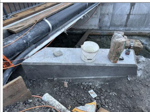
10.12.2025 / Hürbach – ausgeschaltete Bauwerke Ufermauern
