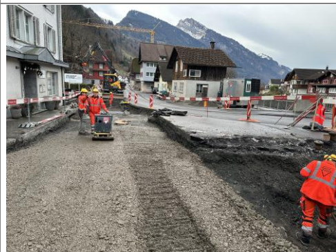
12.12.2025 / Hintere Brücke – Einbau Koffer
