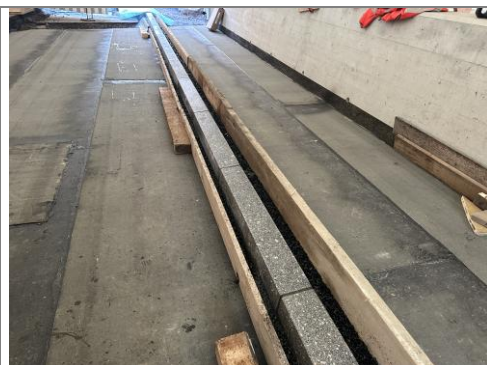
10.12.2025 / Hürbach – Versetzen Randabschlüsse
