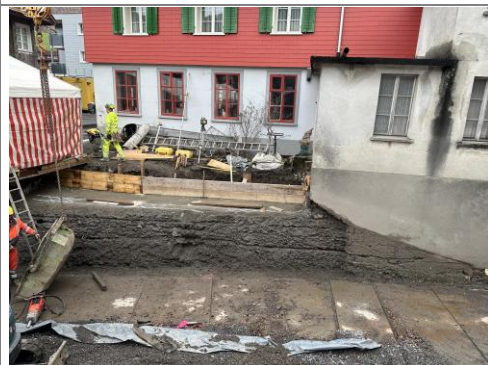
12.12.2025 / Hürbach – Schalung Leitmauer rechte Uferseite
