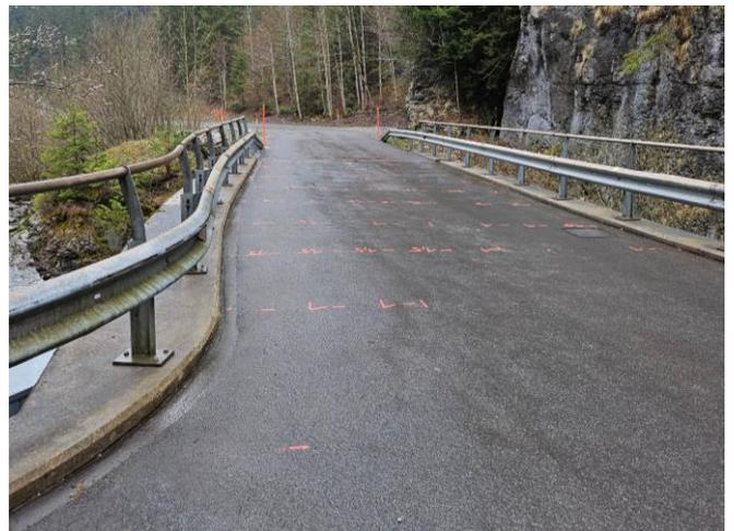
**TS 2 am 26.03.2025: Vorbereitungsarbeiten (Frässtärken anzeichnen) für den Deckbelagseinbau Zwingsbrücke bis Balm.**
