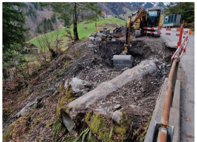
**TS 2 am 03.04.2025: Aushubarbeiten für Auflager des Brückenelements der hinteren Gigenbachbrücke.**
