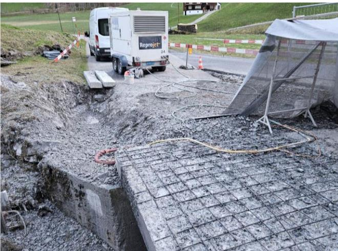
TS 2 am 11.04.2025: Betonabtrag vordere Gigenbachbrücke für Plattenverstärkung.
