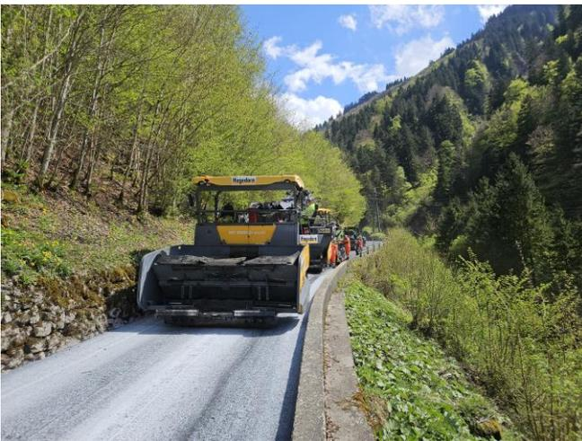
**TS 2 am 23.04.2025: Deckbelageeinbau im Abschnitt Zwingsbrücke bis Balm. Am Vortag wurde der Haftvermittler für den Verbund der Schichten aufgetragen.**
