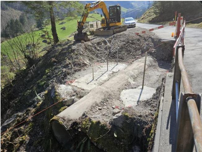
TS 2 am 08.04.2025, hintere Gigenbachbrücke: Foundation mit Mikrobohrpfählen für Auflager des Provisoriums (Notbrücke).
