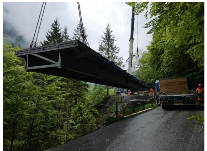
**TS 2 am 09.05.2025: Montage Provisorium (Notbrücke) für die Sanierung der hinteren Gigenbachbrücke. Versetzten der Elementbrücke mit zwei Pneu Kränen.**
