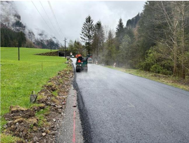
**TS 2 am 17.04.2025: Einbau Tragschicht im Abschnitt Steinweid. Gesamthaft wurden für beide Abschnitte ca. 450 Tonnen Asphaltbelag eingebaut.**
