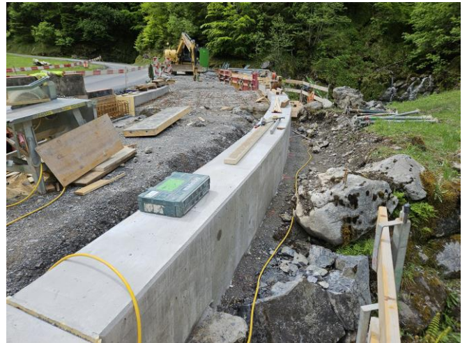
TS 2 am 13.05.2025: Randborde der vorderen Gigenbachbrücke betonieren.
