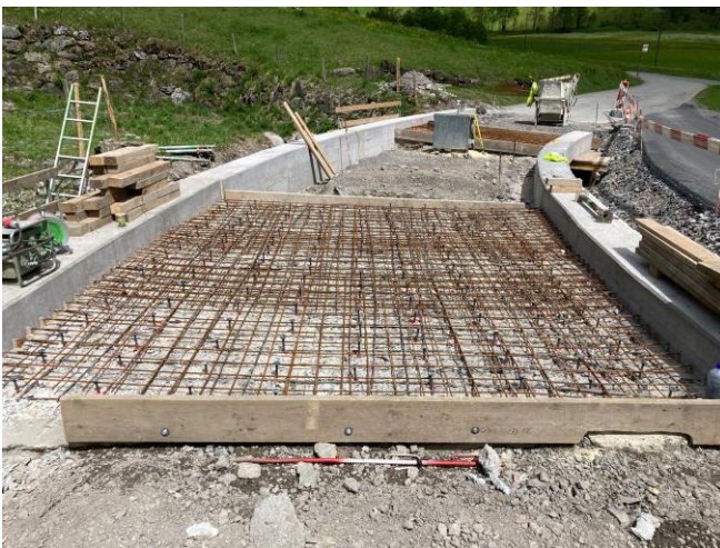
TS 2 am 16.05.2025: Bewehrung für Plattenverstärkung der vorderen Gigenbachbrücke.
