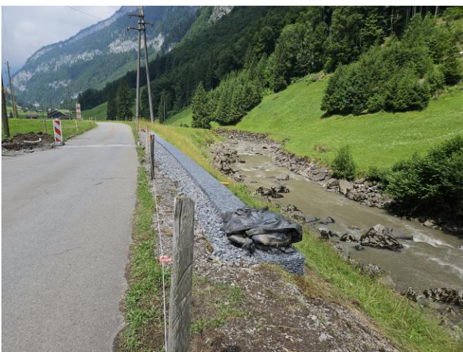
TS 2 am 04.07.2025: Instandstellung Wanderweg mit Steinkörben.
