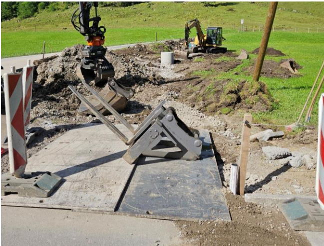
TS 2 am 13.06.2025: Anschluss Entlüftung WGM an Entwässerung.
