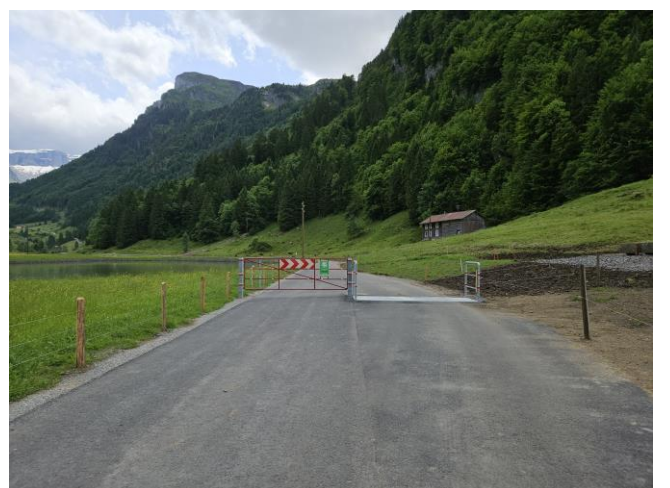
TS 2 am 04.06.2025: Abzäunung, Weiderost entlang Ausweichstelle und Gatter.
