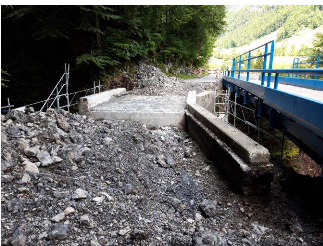
TS 2 am 03.06.2025: Rückbau Randborde und Betonabtrag vordere Gigenbachbrücke.
