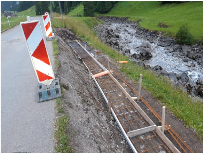
TS 2 am 26.06.2025: Fundation für Instandstellung Wanderweg mittels Steinkörben.
