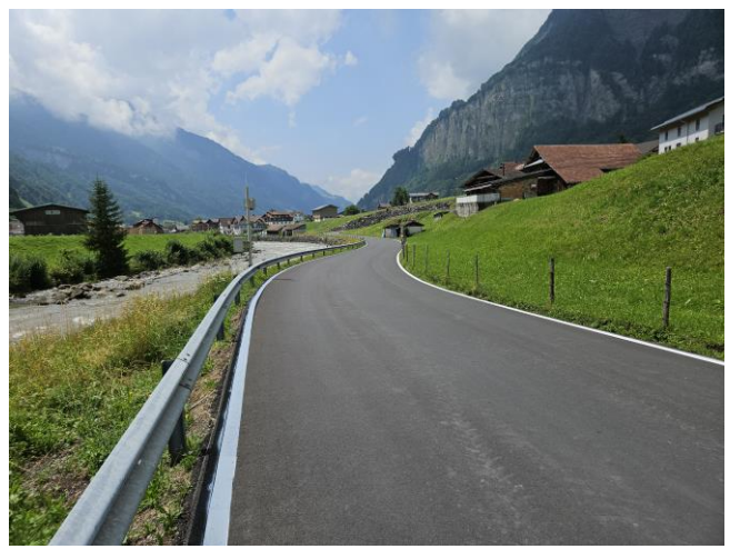
TS 1 am 04.07.2025: Markierung Leitlinie entlang Strassenrand (Stützli bis Einfahrt Fugglen).
