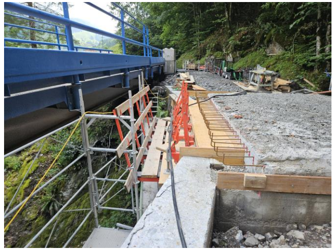
TS 2 am 04.07.2025: Schalung des talseitigen Randbords der hinteren Gigenbachbrücke.
