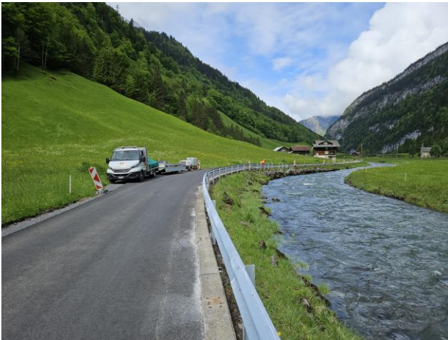
TS 2 am 13.05.2025: Leitschranke im Abschnitt Bergli versetzen.
