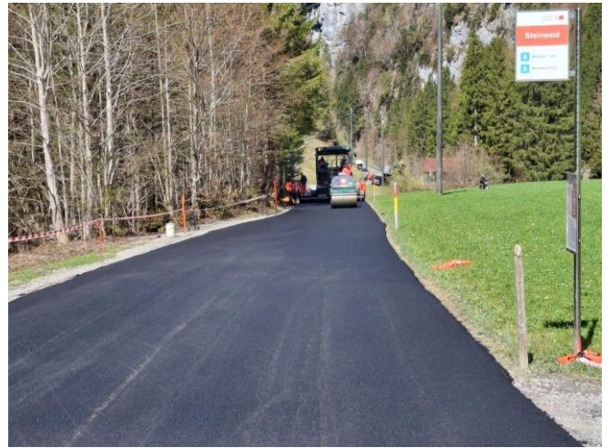
TS 2 am 16.04.2026: Deckbelagseinbau Steinweid.
