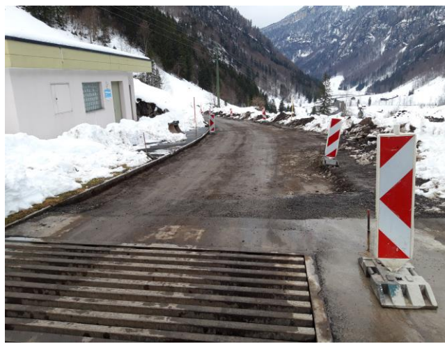
TS 2 am 01.04.2026, Etappe Schönenboden bis Gigenbachbrücken: Belagsrückbau 1. Etappe abgeschlossen.
