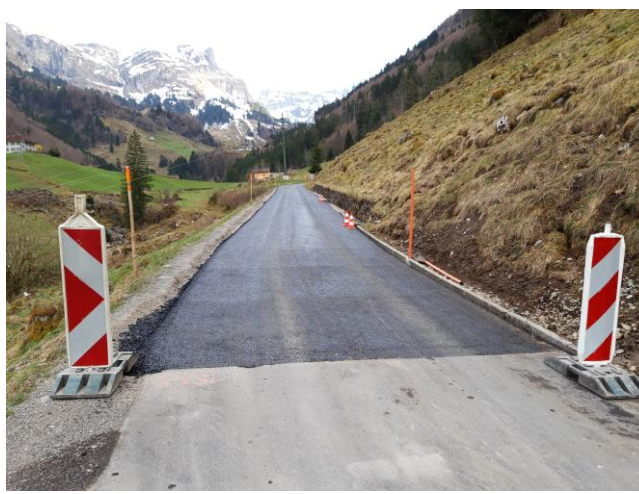
TS 2 am 09.04.2026: Belagsersatz Tragschicht der 2. Etappe zw. Schönenboden und Gigenbach.
