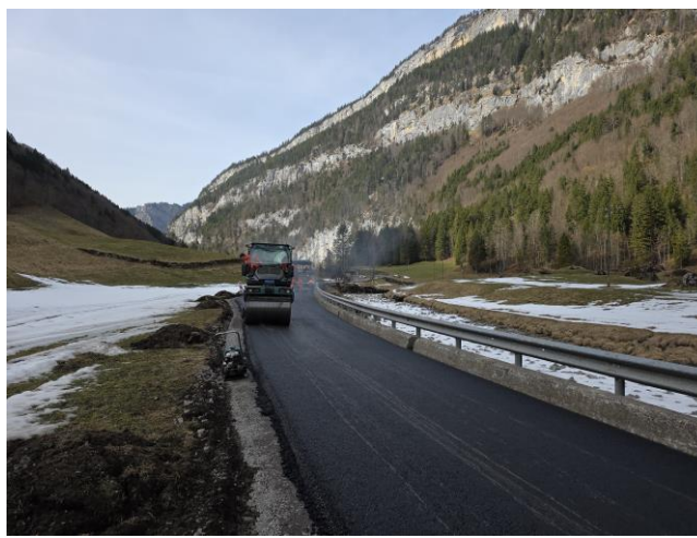
TS 2 am 05.03.2026: Belagseinbau (Tragschichtersatz) der 2. Etappe im Bereich Bergli.
