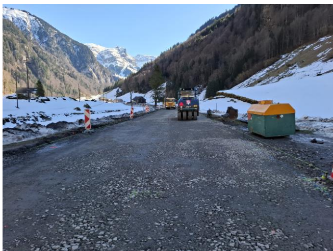
TS 2 am 27.02.2026, 1. Etappe Laui bis Bergli: nach lokalem Fundationsersatz wird die Planie vorbereitet für den Tragschichtersatz im Bereich Laui.
