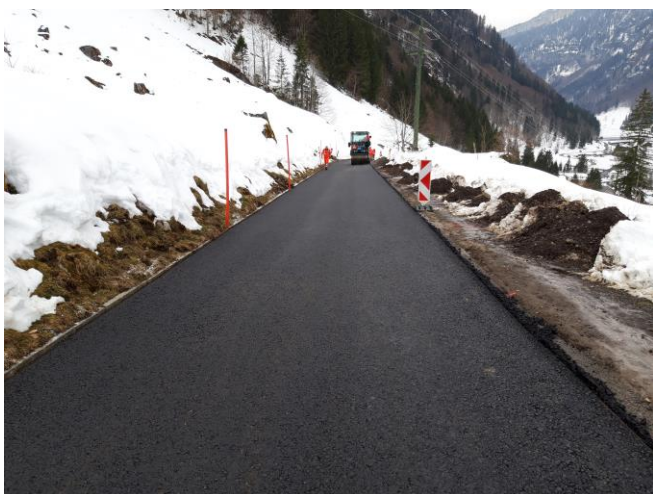
TS 2 am 02.04.2026: Belagsersatz Tragschicht der 1. Etappe zwischen Schönenboden und Gigenbach.
