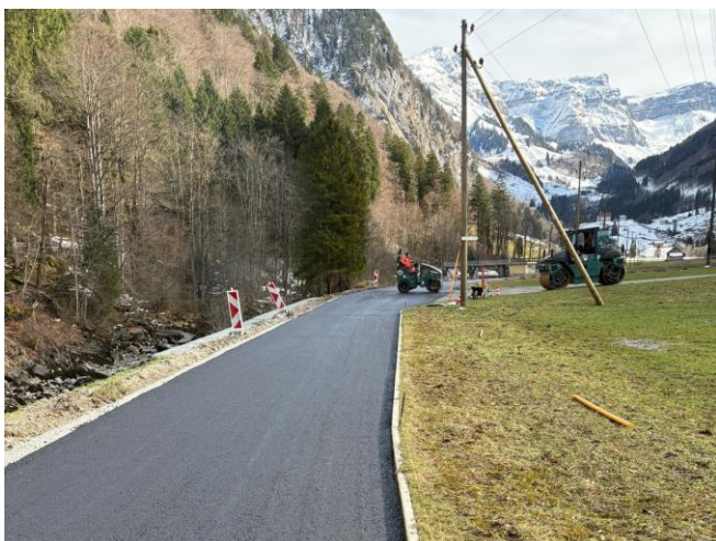
TS 2 am 17.03.2026, Zwischenstück: Belagsersatz im Bereich Mettlen / Wasserbergstrasse. Wetterumschwung Ende April; Schneefall ab 25. März 2026.
