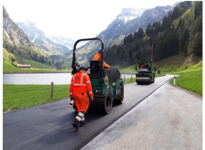
TS 2 am 21.04.2026: Deckbelagseinbau im Bereich Seeberg bis Mettlen.
