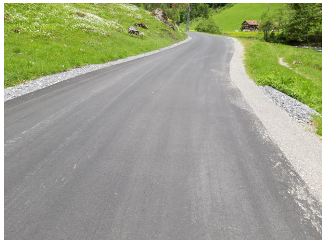
TS 2 am 19.05.2026: Vorabnahme Teilstrecke 2: Sickerpackung bergseitig und Kiesbankett im Bereich Seeberg.
