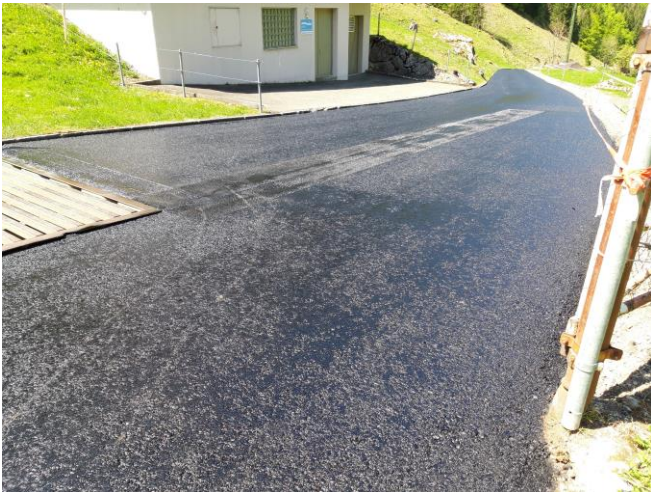
TS 2 am 27.04.2026: Vorbereitungsarbeiten für Deckbelag im Bereich Schönenboden bis EBS-Zentrale Seeberg; Asphaltbewehrung kleben und Haftvermittler aufspritzen.
