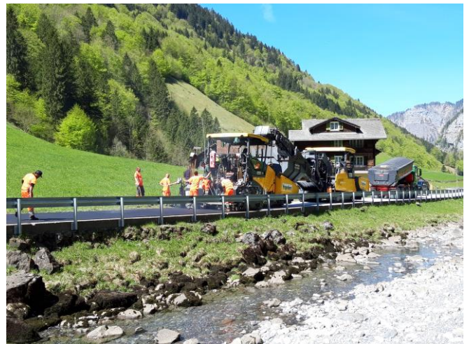
TS 2 am 24.04.2026: Deckbelagseinbau im Bereich Seeberg bis Mettlen.
