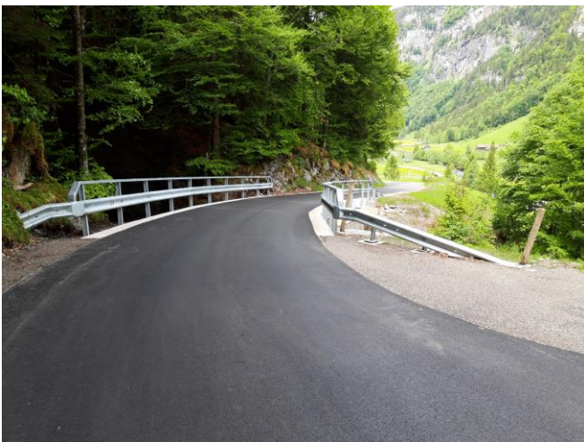
TS 2 am 19.05.2026: Vorabnahme Teilstrecke 2: Obere Gigenbachbrücke.
