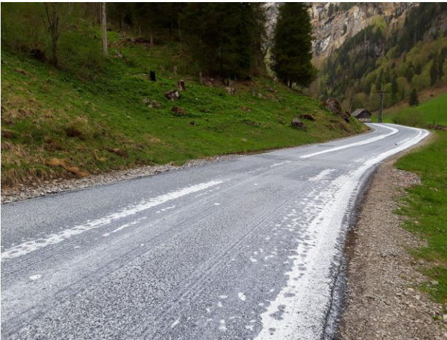
TS 2 am 20.04.2026: Auftrag Haftvermittler und Kalkmilch vor Deckbelagseinbau im Bereich Mettlen bis Seeberg.
