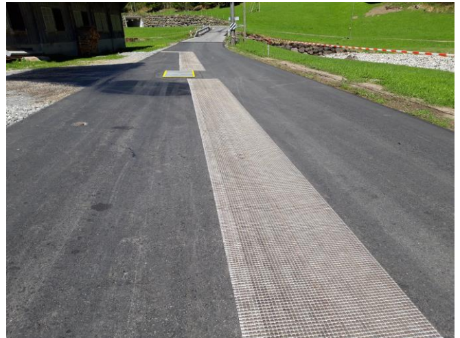
TS 2 am 23.04.2026: Vorbereitungsarbeiten vor Deckbelagseinbau wie z.B. Asphaltbewehrung bei Fugen in Tragschicht anbringen.
