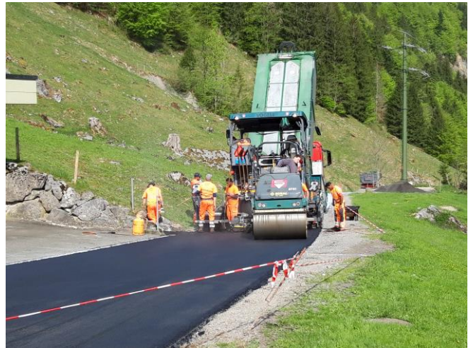
TS 2 am 28.04.2026: Deckbelagseinbau Schönenboden bis EBS-Zentrale.
