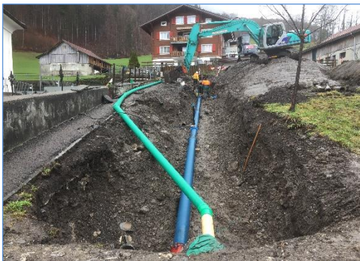
Leitungsverlegung Friedhofsanierung Ost
