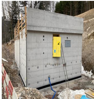
Rohbau mit Einstieg Reservoir
