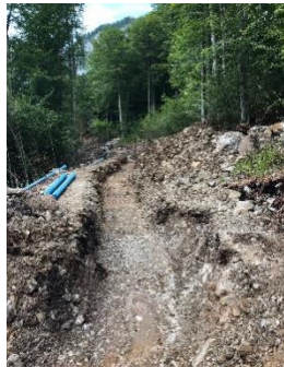
Graben für die Wasserleitung
