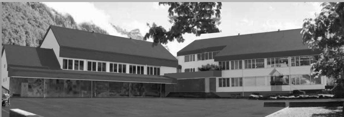
SCHULHAUS MUOTA SANIERUNG GEBÄUDEHÜLLE
